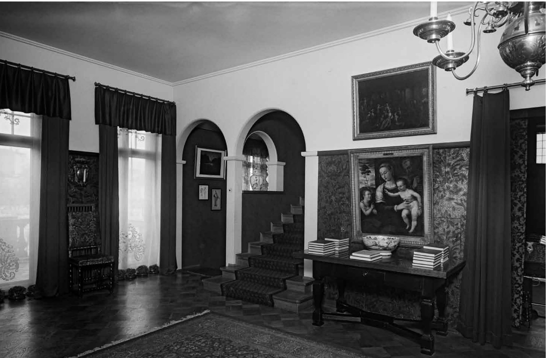
22. Pääkerroksen keskeinen halli. Saariselle tyypilliset kaariaukot avautuvat pääportaaseen. Hjeltin kokoelman taideteokset täydensivät interiööriä.
