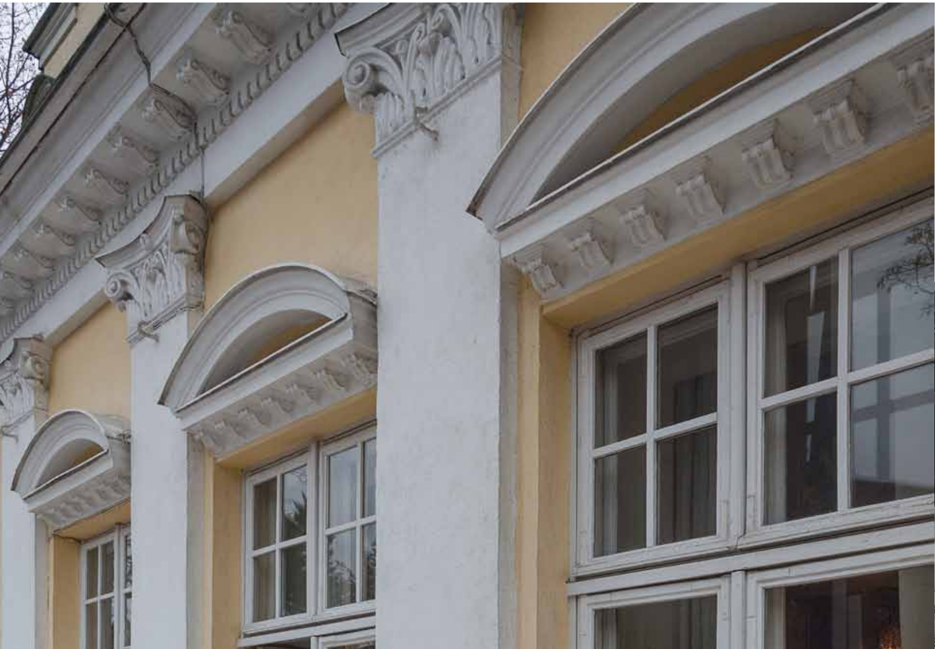
2. Pääjulkisivun yksityiskohtia: arkkitehti Gustaf Estlanderin käyttämiä klassisia arkkitehtuurimuotoja myöhäisjugend-talossa. Arno de la Chapelle.
