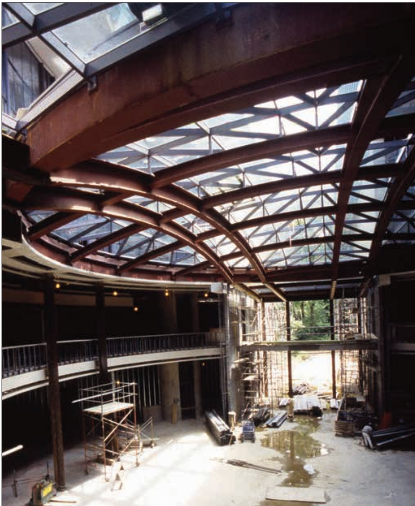
61. Fasi del cantiere con la messa in opera della struttura reticolare a maglia triangolare di copertura dell'atrio centrale.
