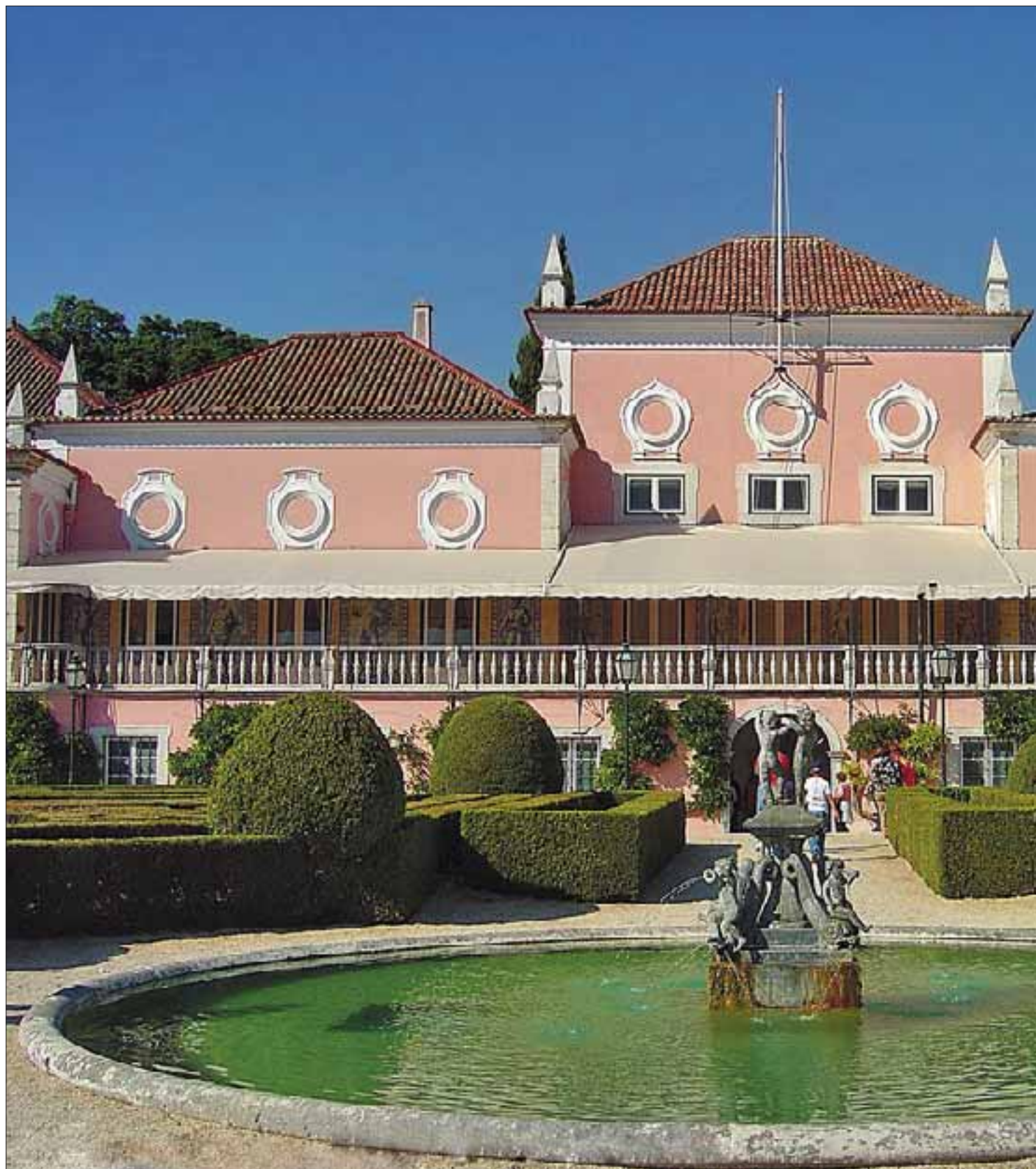
Giardino della Cascata nel Palazzo presidenziale di Belém.
