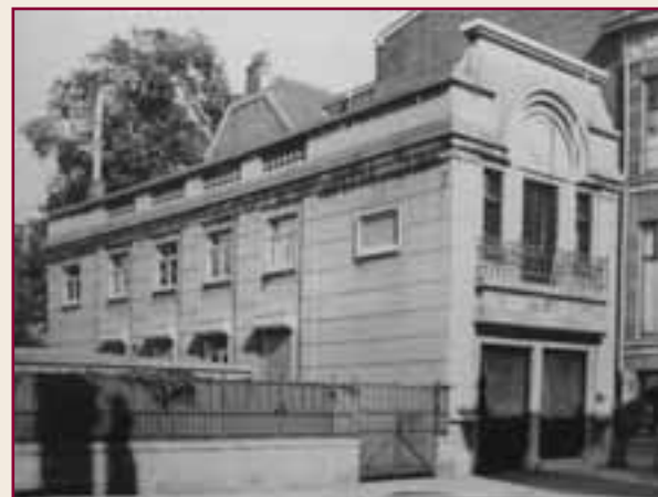
Fig. 10. Vista della facciata longitudinale del Padiglione della Cancelleria da Zeestraat. Foto di repertorio 1948 circa.
