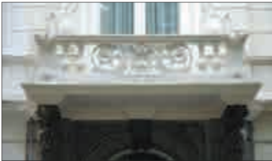
Particolare del balcone.
