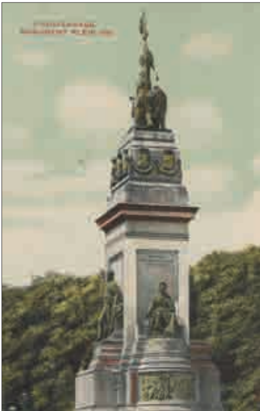
Monumento Plein 1813 – Lato laterale.
