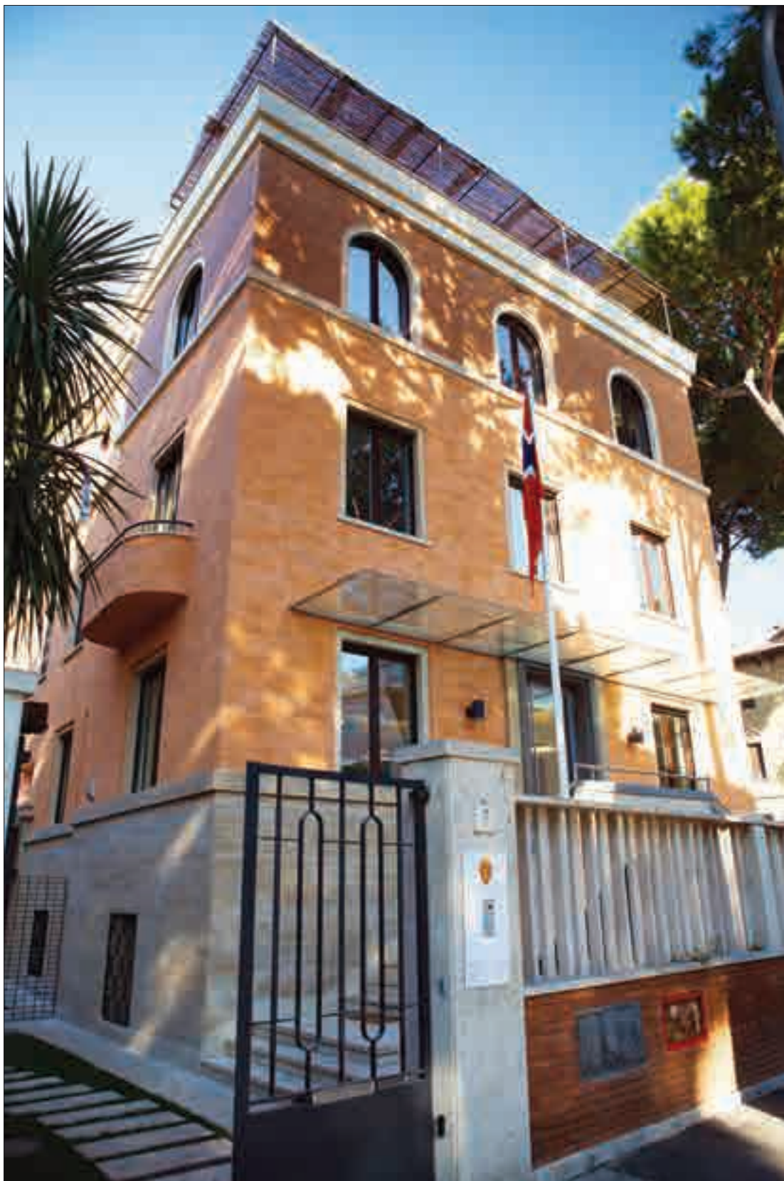
Kontorbygningen til Den kgl. norske ambassade i Roma. Foto: Mathias Rongved, Den kgl. norske ambassade.
