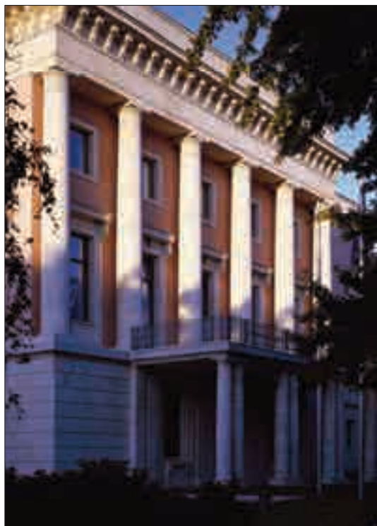
La pianta dell'edificio consta di una superficie di circa 10.000 metri quadrati. La facciata principale, in stile rinascimentale e dai rivestimenti in travertino romano, è orientata verso il Tiergarten ed è suddivisa in tre assi. È dominata da una zona mediana avanzata, un portico con sei colonne. Di fronte a questo risalto si vede un'altana, altro portico meno alto con quattro paia di colonne e un parapetto in ferro battuto. Foto di Massimo Listri.
